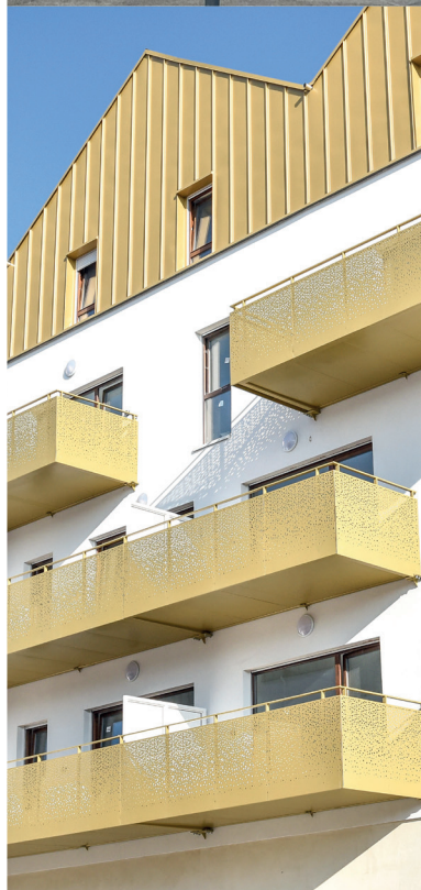
Immeuble en bois, REMAVERT à Reims (51). © Frank Kauff.
